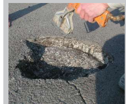
3. Sécher au chalumeau ou à l'air comprimé
